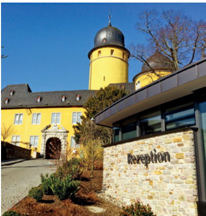
> 德国 ADG 总部
